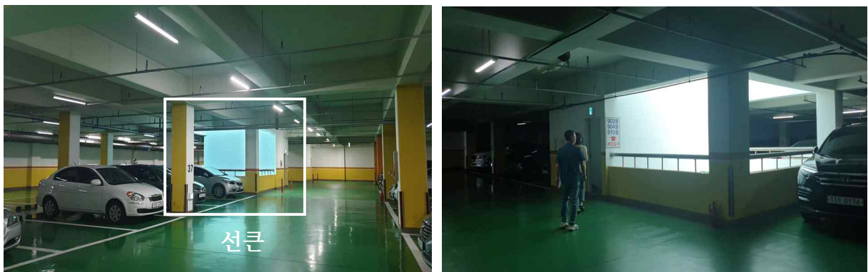
<그림 23> 선큰이 설치된 지하주차장
