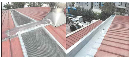
송촌전천후 게이트볼장 누수 보수
